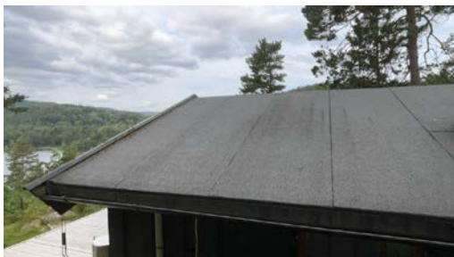
Del av taktekking.
