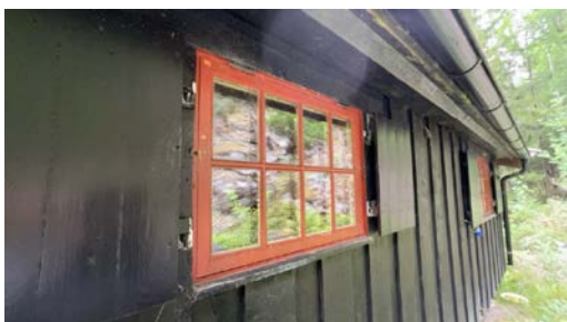
Eksempel på vindu i yttervegg.
