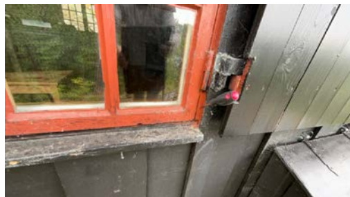
Stikk kontroll på vinduer er utført.
