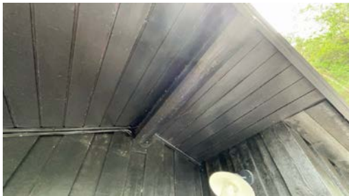
Konstruksjon sett fra terrasse.
