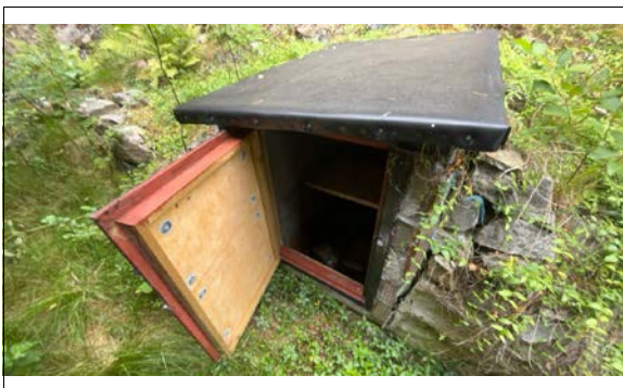
Liten installasjon for sval oppvaring.
