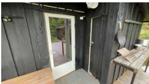
Hovedinngangsdør og dør inn til toalettrom.
