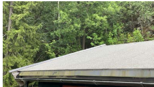
Del av taktekking.
