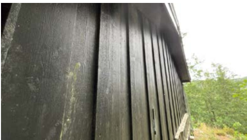
Del av vegg.
