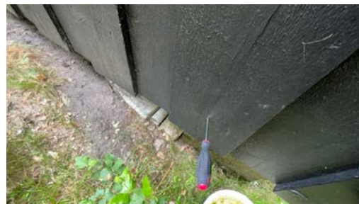
Del av vegg.
