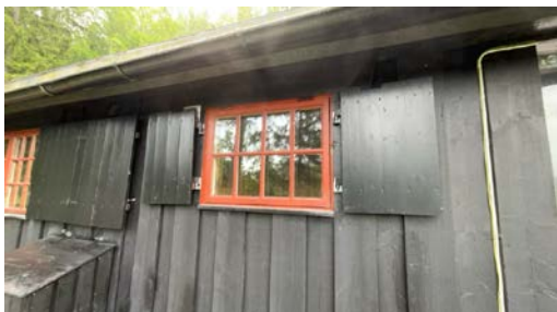
Eksempel på vindu i yttervegg.
