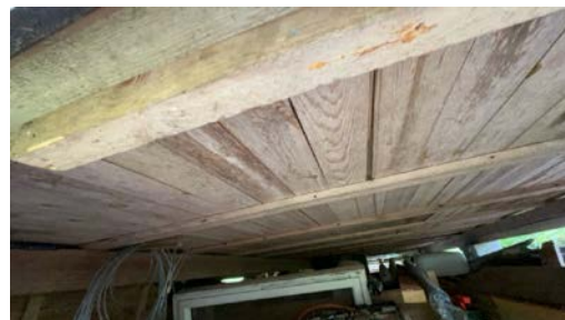
Del av etasjeskille sett fra undersiden.
