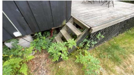
Trapp opp til terrasse.
