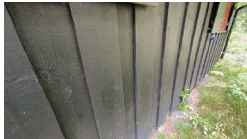
Del av vegg.
