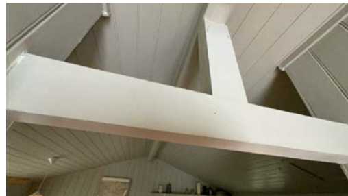
Tak sett fra innsiden.
