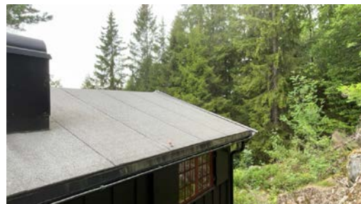
Del av taktekking.
