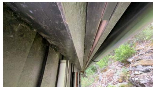
Del av takkonstruksjon.
