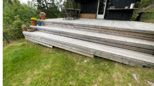
Trapp opp til terrasse.
