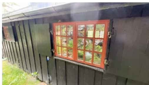
Eksempel på vindu i yttervegg.
