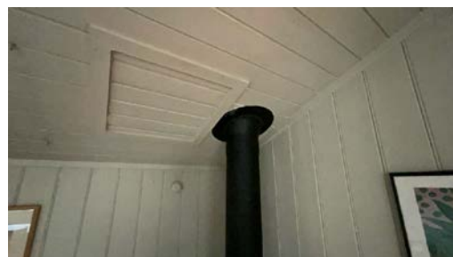
Del av pipe.
