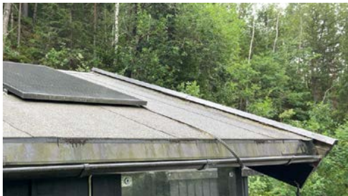
Del av taktekking.
