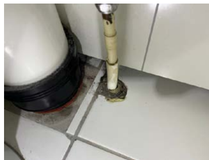
Utett rørgjennomføring
