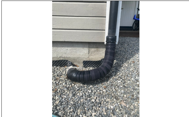
Bilde av forlengelsen av drensør.
