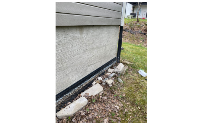
Bilde av ettermontert klemlist på knotteplasten rundt boligen.
