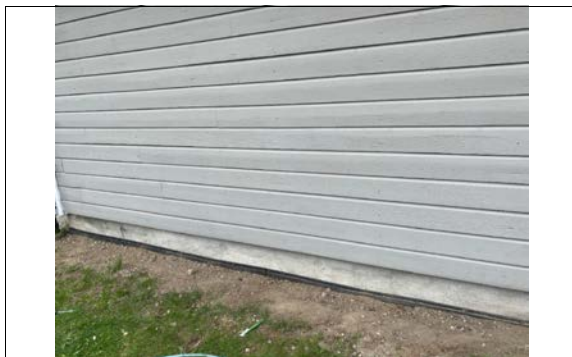
Bilde av ettermontert klemlist på knotteplaten rundt boligen.
