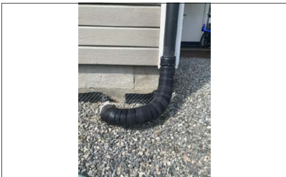
Bilde av forlengelsen av drensør.
