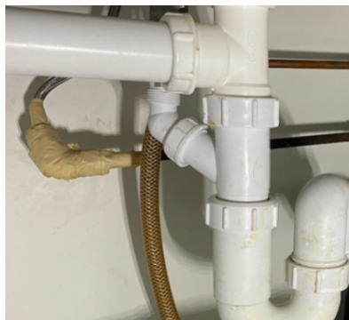
Bruk av tape mot vannledninger.
