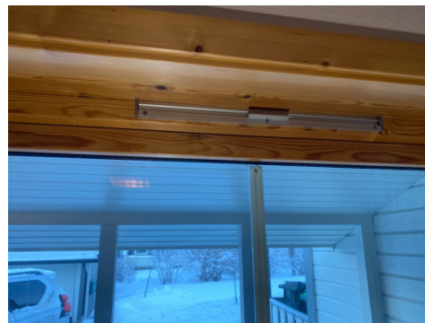
Boligen har ventiler i vinduer.
