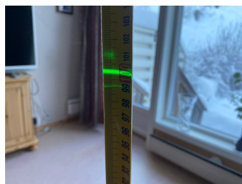
Måling av planavvik.
