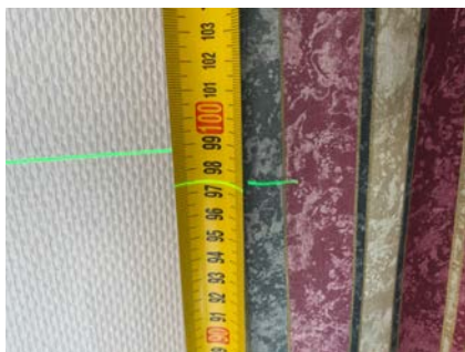
Måling av planavvik innenfor 2. m.
