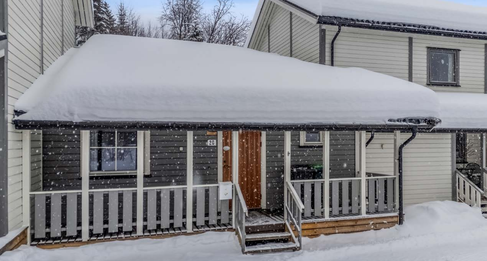
Inngangspartiet har en tretrapp med strekkmetall i trinn, og fasaden er kledd med liggende bordkledning.
