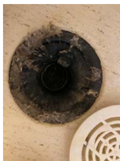
Svellinger rundt avtrekkskanal.
