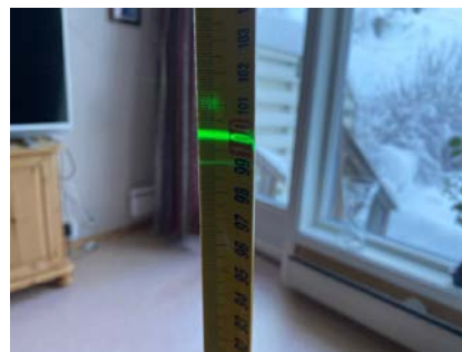
Måling av planavvik.
