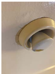
Svellinger rundt avtrekkskanal.
