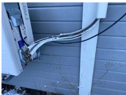
Isolasjon mot rør mangler.
