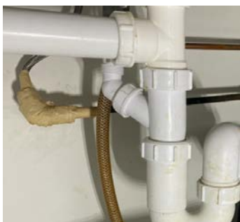
Bruk av tape mot vannledninger.
