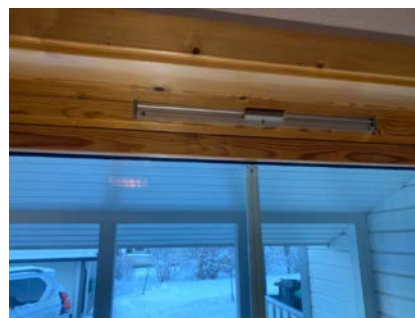
Boligen har ventiler i vinduer.
