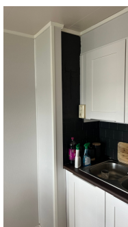
Eksempel på innkledning av pipen
