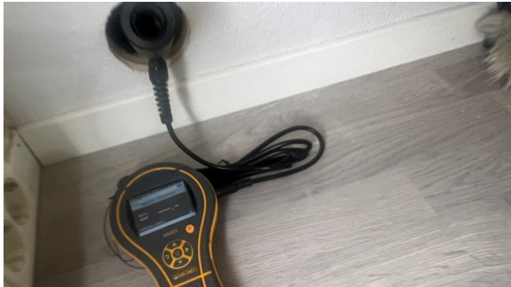
Fuktmåling i veggen inn mot badet
