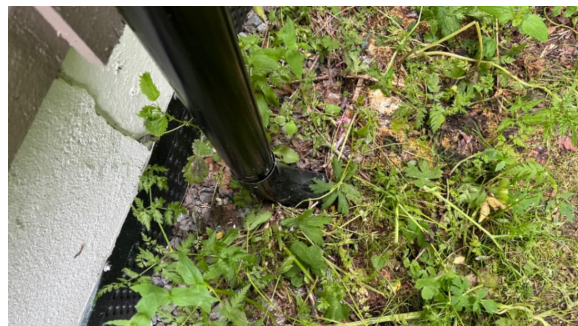
Eksempel på eil avslutning av nedløpsrør
