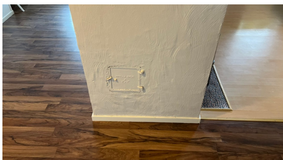
Sotluke uten ubrennbart materiale under.
