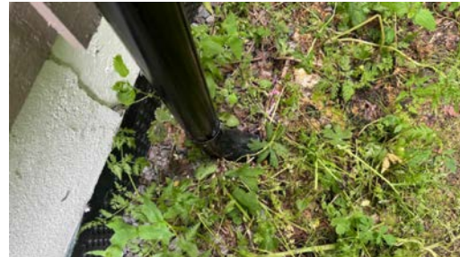
Eksempel på eil avslutning av nedløpsrør
