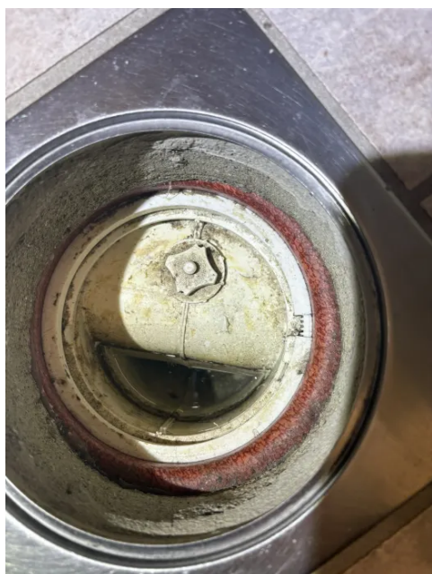
Sluk i del av bad eldre del.
