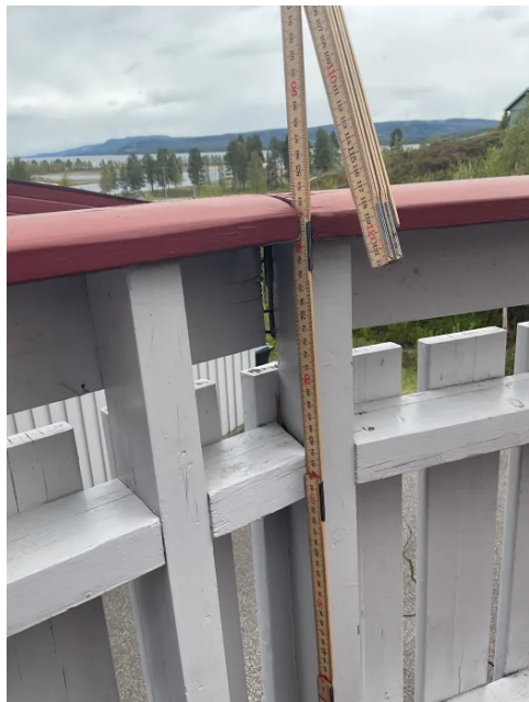
Høyde rekkverk.
