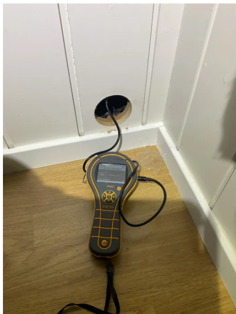
Hulltaking i tilstøtende rom.
