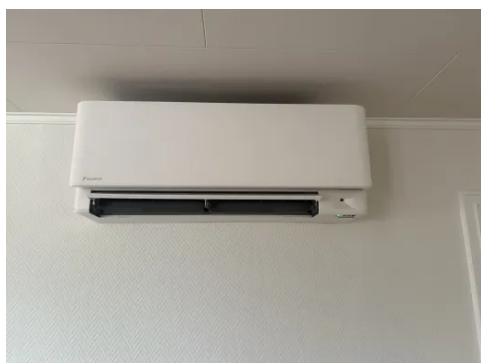
Luft/luft varmepumpe.
