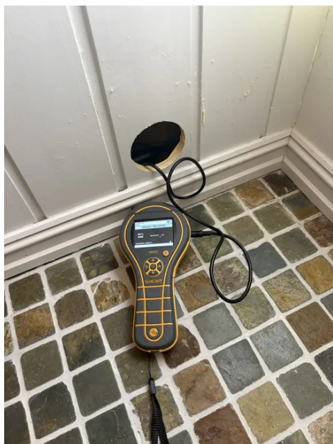
Hulltaking i tilstøtende vegg.
