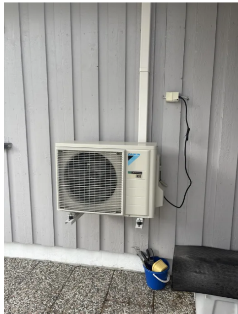
Luft/luft varmepumpe.
