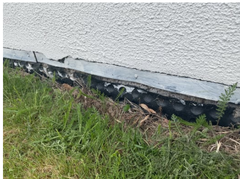
Svikt i tetting mellom list og grunnmursplast.
