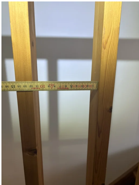
Avstand rekkverk.
