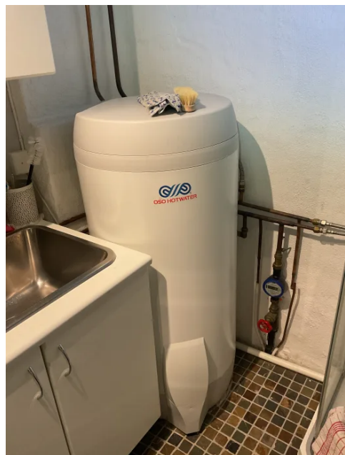
Varmtvannsbereder.
