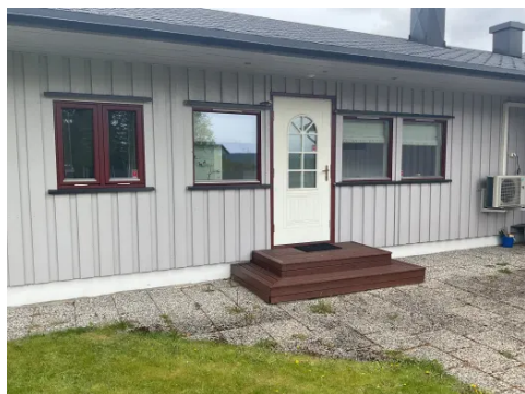
Vinduer og dør i tilbygg.
