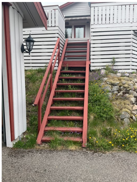
Trapp fra terrasse til terreng.
