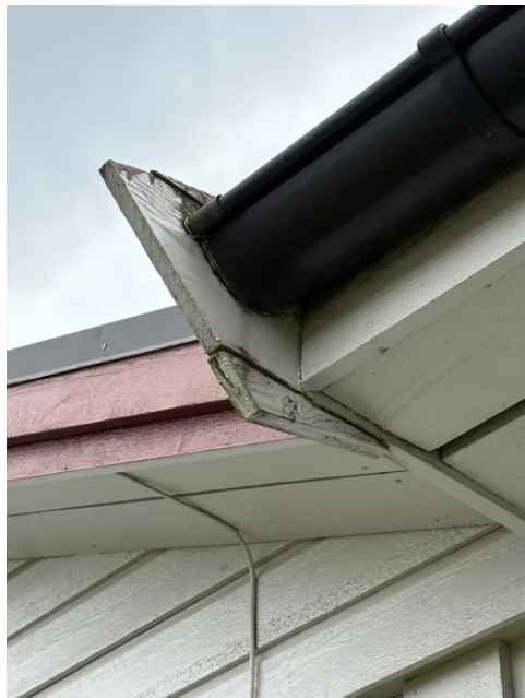
Fuktskadede vindskie.
