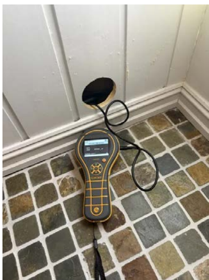
Hulltaking i tilstøtende vegg.
