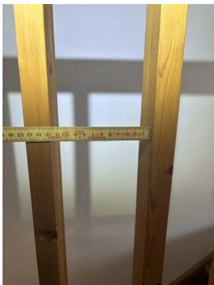
Avstand rekkverk.
