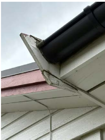
Fuktskadet vindskie.
