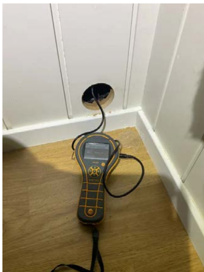
Hulltaking i tilstøtende rom.
