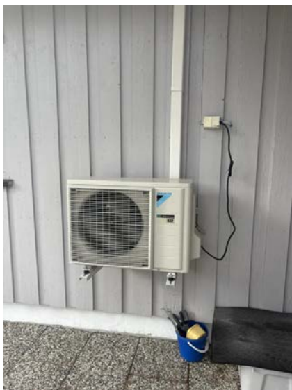
Luft/luft varmepumpe.
