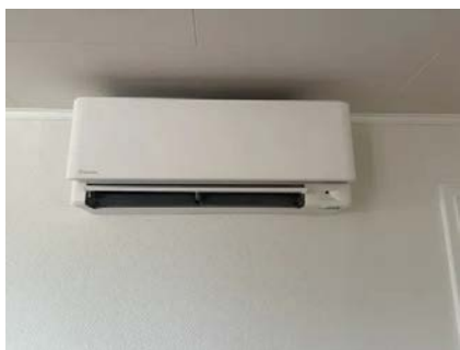
Luft/luft varmepumpe.
