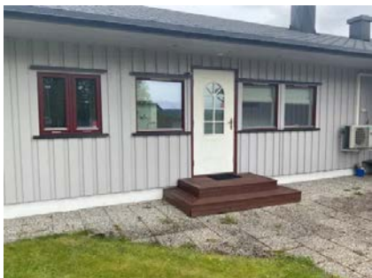
Vinduer og dør i tilbygg.
