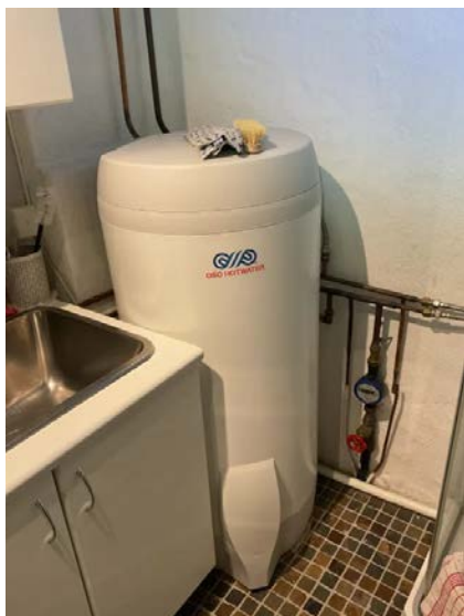
Varmtvannsbereder.
