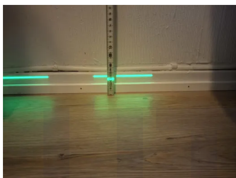
Etasjeskillet er kontrollert med nivelleringslaser.
