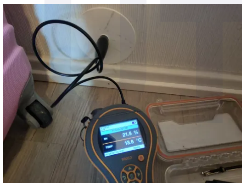
Bilde fra fuktmåling i veggkonstruksjon tilstøtende våtsone.
