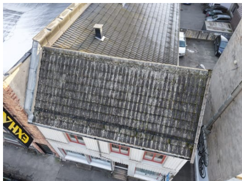
Taket er tekket med metallplater.
