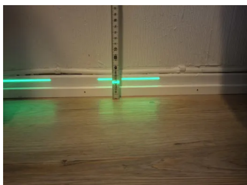
Etasjeskillet er kontrollert med nivelleringslaser.
