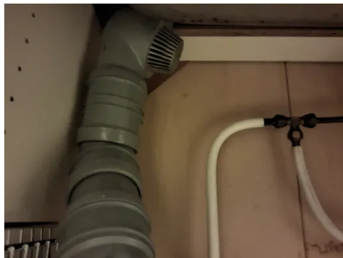
Det registreres vakumventil i kjøkkeninnredning.
