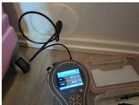
Bilde fra fuktmåling i veggkonstruksjon tilstøtende våtsone.
