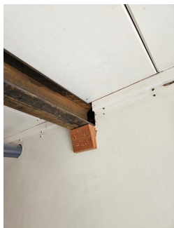
Forsterket bjelkelag i underliggende himling.
