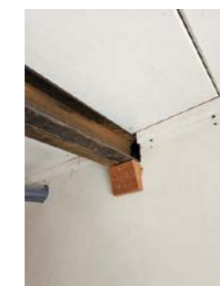
Forsterket bjelkelag i underliggende himling.
