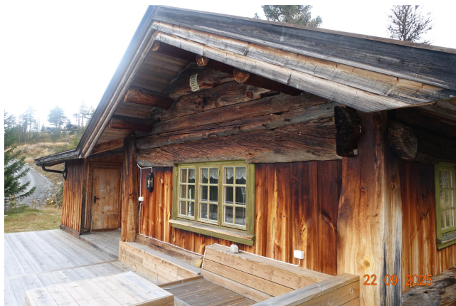
Plassbygget tak med runde åser til takkonstruksjonen.
