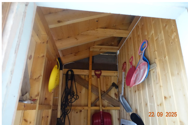
Plassbygget takkonstruksjon synlig i bod rommet.
