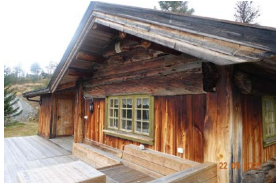
Plassbygget tak med runde åser til takkonstruksjonen.
