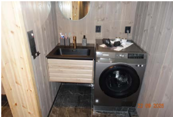
Vask montert i vaskerommet
