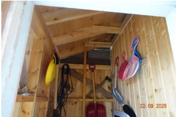
Plassbygget takkonstruksjon synlig i bod rommet.
