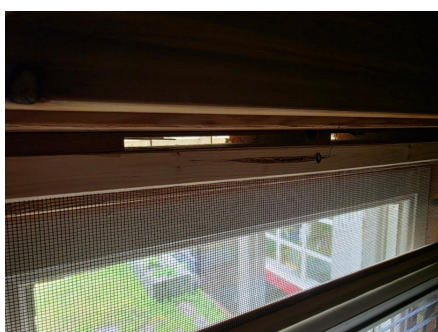
Ventiler i vindu på soverom.
