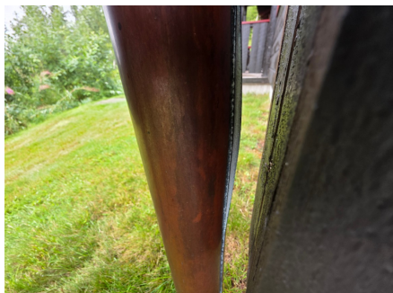
Frostsprengt nedløp
