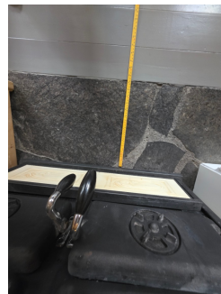
38cm til brennbart materiale (gulv)
