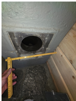
Under 30cm til brennbart materiale
