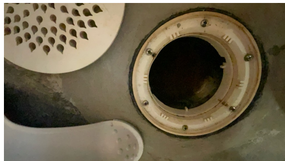
Ingen synlig bruk av membran "mansjett" i sluk
