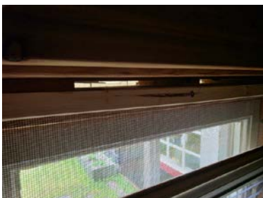
Ventiler i vindu på soverom.
