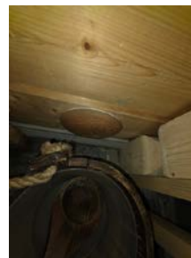
Vegg ventil i yttervegg plassert ned ved gulvet
