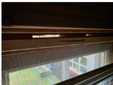
Ventiler i vindu på soverom.
