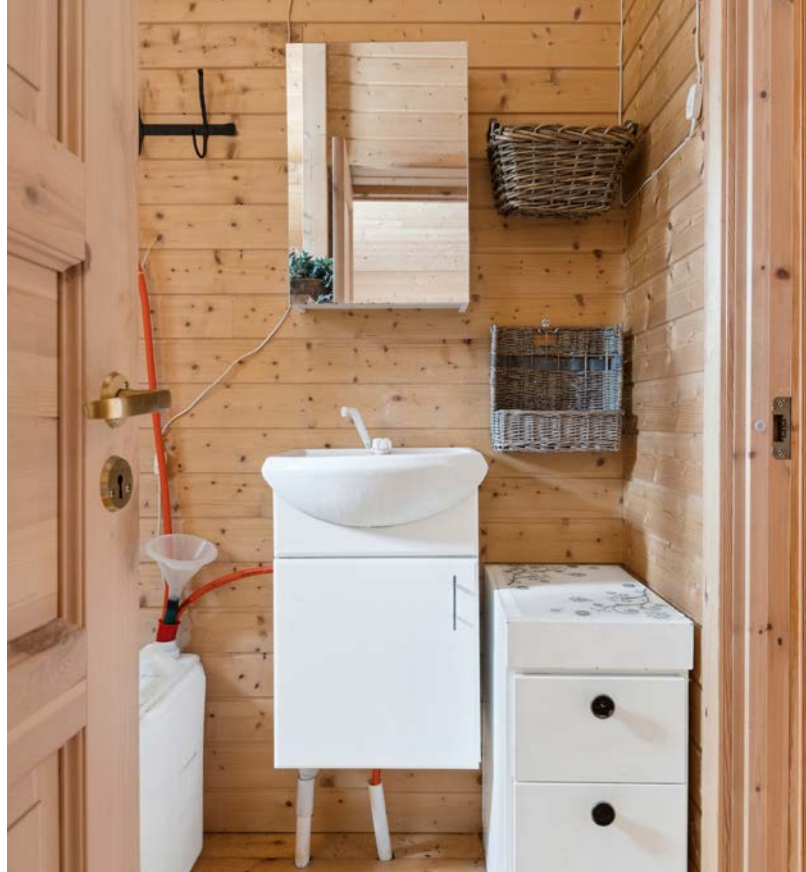
Det er ikke påvist synlige skader forårsaket av vannsøl på befaringsdagen.
