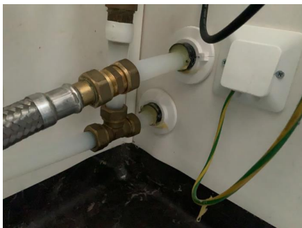
Tettmuffe er erstattet med annet tettemiddel.
