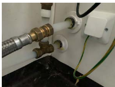
Tettmuffe er erstattet med annet tettemiddel.
