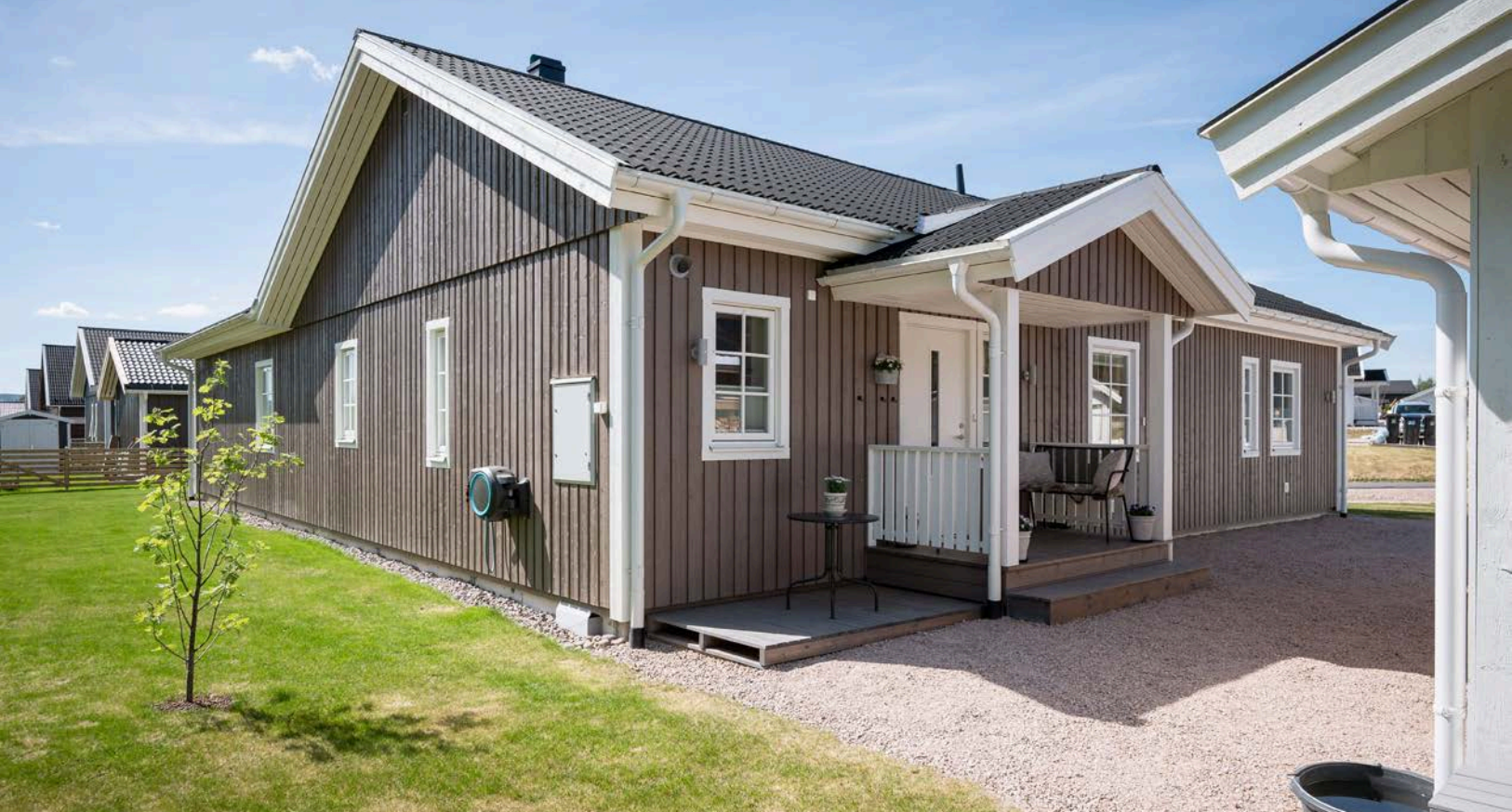
Tomten er opparbeidet med plen og beplantning. Montert gjerde i 2023. Gruset gårdsplass.
