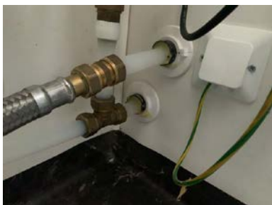
Tettmuffe er erstattet med annet tettemiddel.
