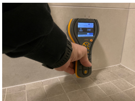
Fuktmåling på overflate i dusjsone
