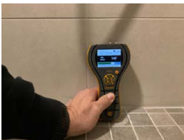
Fuktmåling på overflate i dusjsone
