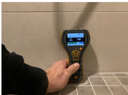
Fuktmåling på overflate i dusjsone
