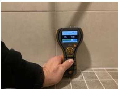
Fuktmåling på overflate i dusjsone
