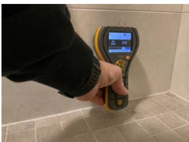
Fuktmåling på overflate i dusjsone
