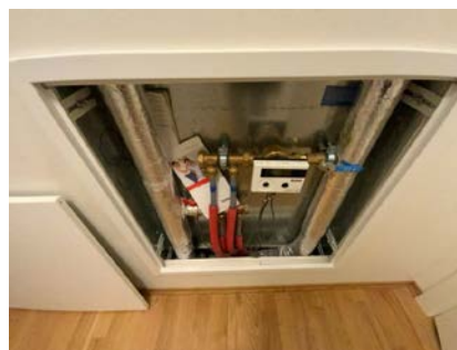
Besiktigelse av røropplegg.
