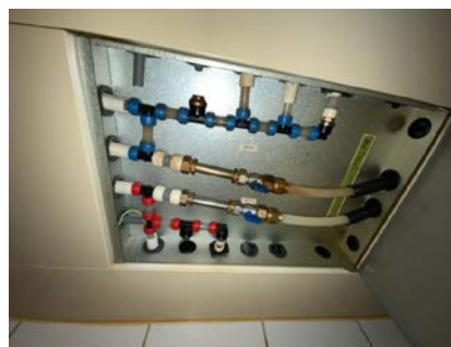
Besiktigelse av røropplegg.
