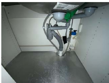
Besiktigelse av røropplegg.
