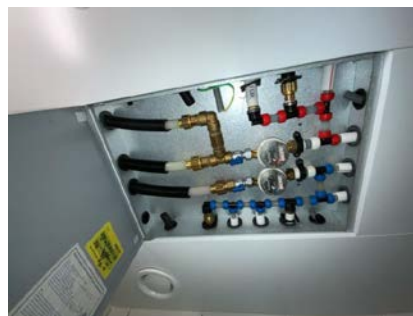
Besiktigelse av røropplegg.
