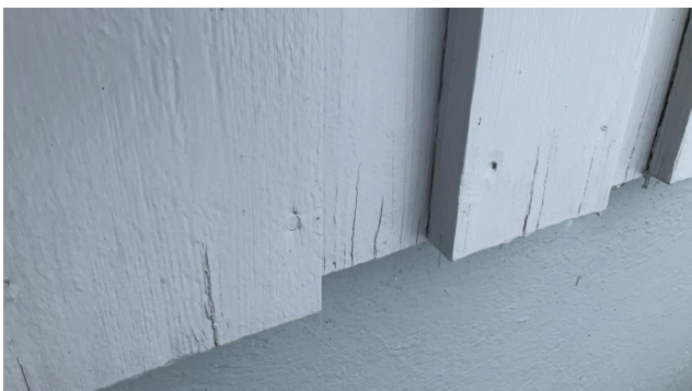
Værslitt trebordkledning.
