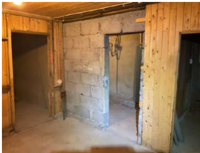
Veger av lettklinkerstein og panelvegger.
