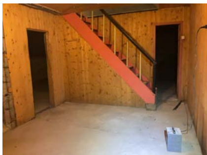
Åpning i rekkverk på 27 cm.
