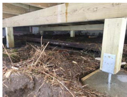
Fundamentering av terrasse.
