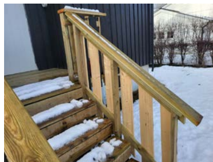
Trapp er fundamentert på mark.
