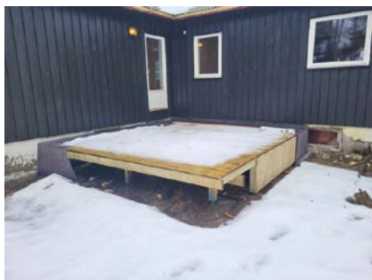
Snødekt terrasse under befaring
