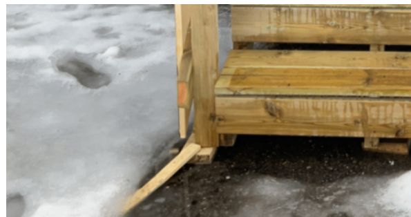
Trapp er fundamentert på mark.
