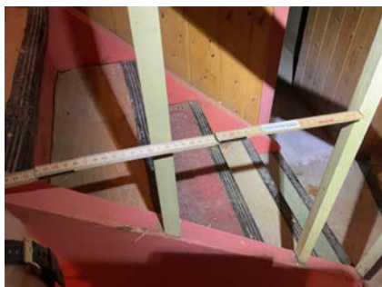
Åpning i rekkverk på 27 cm.
