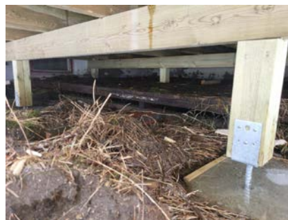
Fundamentering av terrasse.
