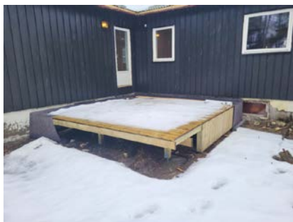
Snødekt terrasse under befarings
