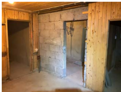
Veger av lettklinkerstein og panelvegger.
