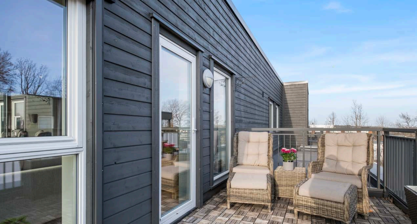
Sydøstvendt takterrasse på ca. 11 kvm. med adkomst fra stua. Trehellene på terrassene er nå fjernet.
