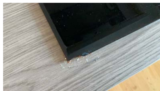
Sprekk i platetopp.
