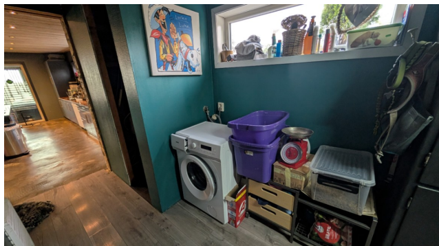
ETASJE 1 > BAD (UNDER ARBEID)
