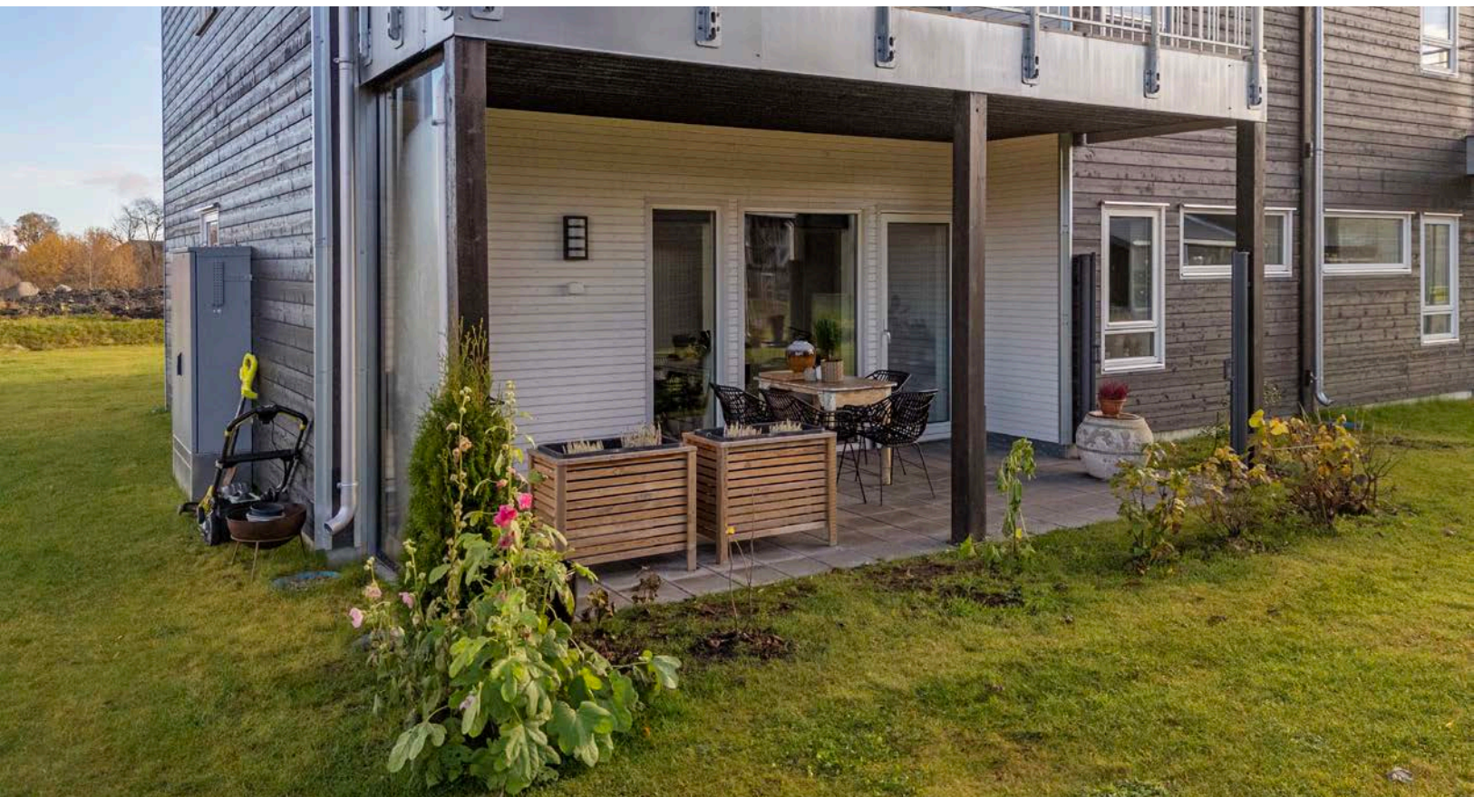
Overbygget uteplass utenfor stue.
