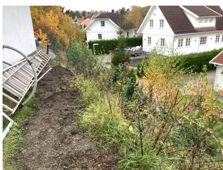
Gjerde må repareres.
