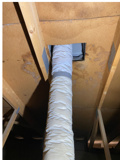
Fuktskjolder rundt gjennomføring.
