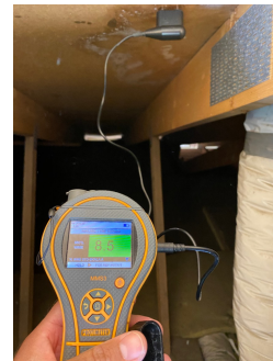
Ingen påvist fukt i plater på befaringstidspunktet.
