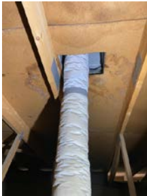
Fuktskjolder rundt gjennomføring.
