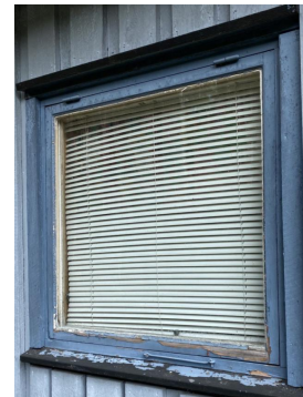
Værslitte vinduer med en del manglende kitt på rammer.
