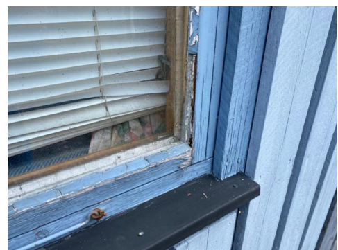
Værslitte vinduer med en del manglende kitt på rammer.
