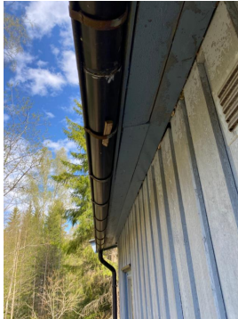
Takrenne understøttet med treflis.
