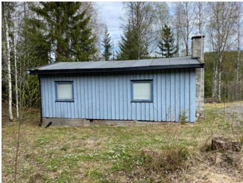
Svai i takkonstruksjonen
