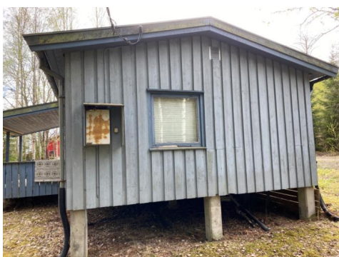
Betongpilarer under hytte
