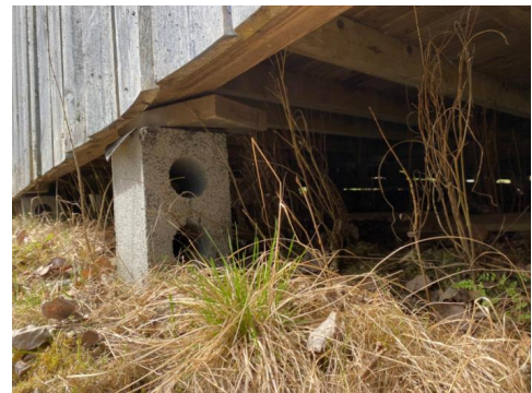
Terrasse med fundamenter av løse Lecablokker
