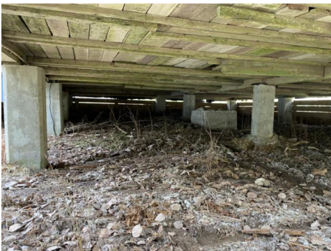
Betongpilarer under hytte
