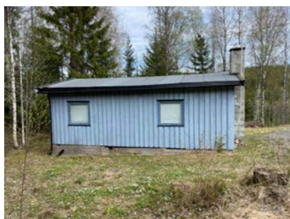
Svai i takkonstruksjonen
