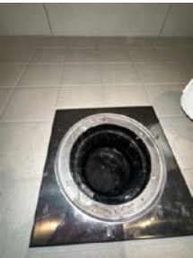
Plastsluk med klemring for membran
