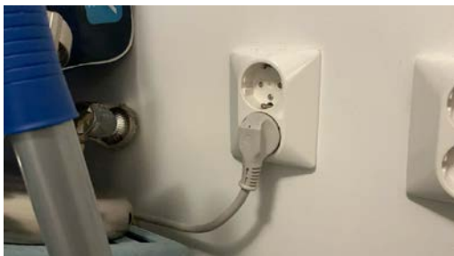
Bereder tilkoblet via stikkontakt
