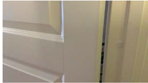
Hakk i dør til bad
