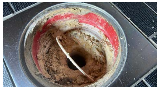
Ikke konstatert membran i sluket.
