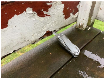
Råteskadet rekkverksbord.
