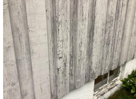
Værslitt bordkledning.
