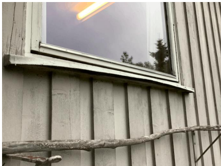
Skadet vannbrettbeslag.
