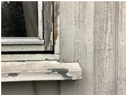
Omramming er ført helt ned til vannbrett.
