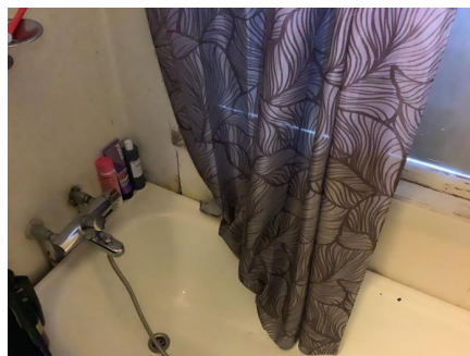
Vindu er plassert i våtsonen.
