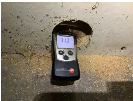
Hulltaking, og påforing er våt.
