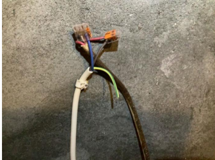
Varmtvannstank er tilkoblet via Wago.
