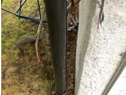
Frostsprengt nedløpsrør.
