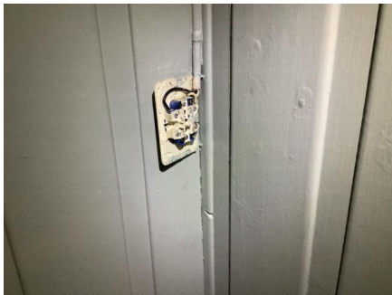
Varmtvannstank er tilkoblet via Wago.
