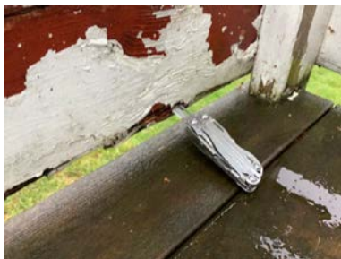
Råteskadet rekkverksbord.
