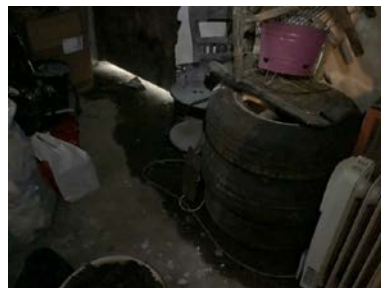
Regnvann renner rett inn i kjeller.
