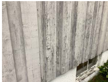
Værslitt bordkledning.
