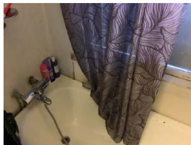
Vindu er plassert i våtsonen.
