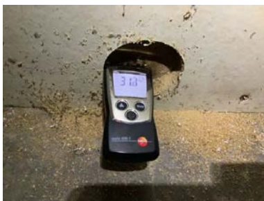
Hulltaking, og påforing er våt.
