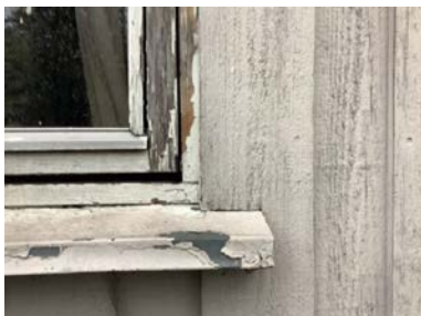
Omramming er ført helt ned til vannbrett.
