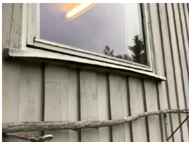
Skadet vannbrettbeslag.
