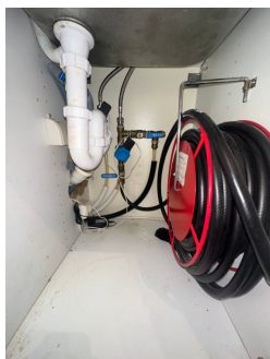
Rørapplegg i kjøkkenbenk med Waterguard
