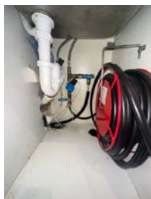
Røropplegg i kjøkkenbenk med Waterguard
