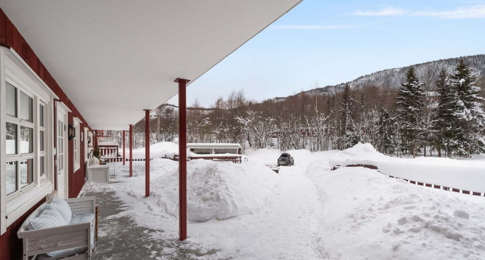
Inngangsparti - enkel tilgang fra bakkeplan eller fra parkeringskjeller og heis opp.
