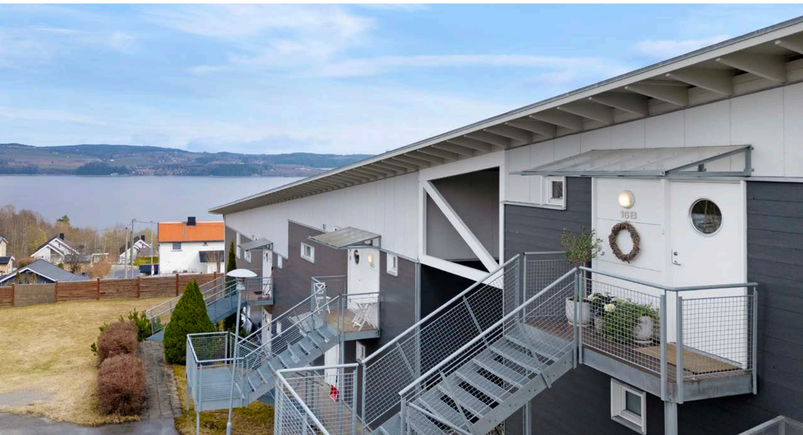
Adkomst via utvendig trapp.
