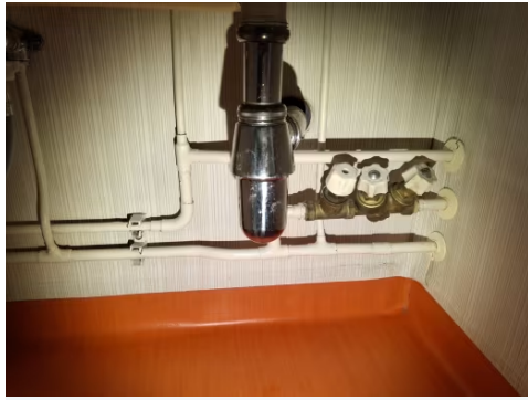
Synlige vannrør av kobber.
